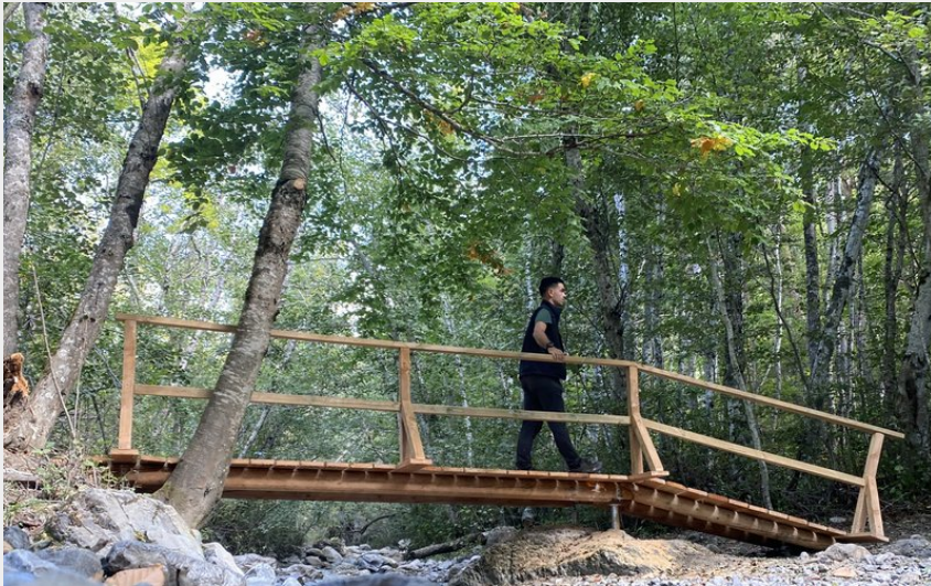
Passerelle de la Peyrouse (CCSB)
