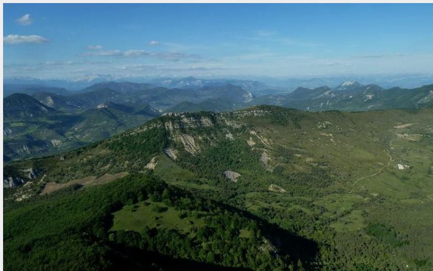
Vue panoramique depuis le sommet (CCSB)
