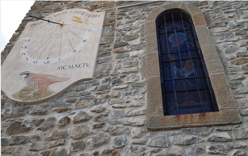
Crédit photo : Cadran solaire de Ribeyret (Office de Tourisme Sisteron Buëch)
