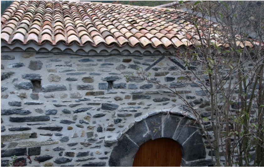
Crédit photo : Façade et porche d'entrée (Claude Aigon)
