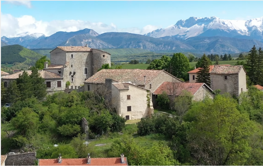
La Bâtie-Montsaléon (CCSB)
